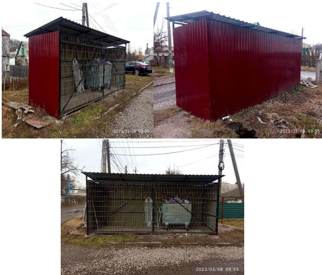
Рис. 23. Контейнерний майданчик багатоквартирного будинку м.Погребище, вул. Хмельницького, 94
